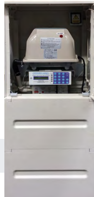
Armoire de commande des Actiblocs®
